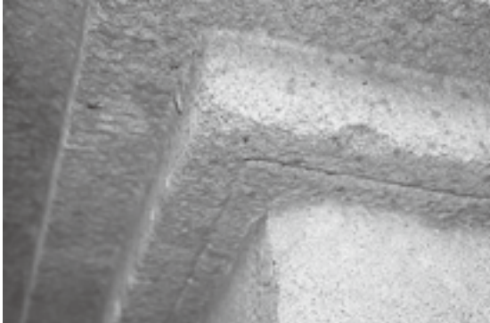
笠の軒裏には雨水の水切り加工が施されている
